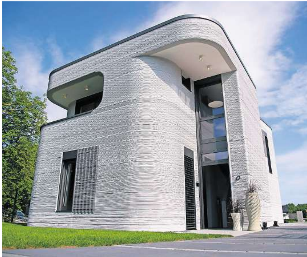
Das erste Haus aus dem Drucker wurde Ende Juli in Beckum eingeweiht. An der Außenfassade sieht man die mittels eines 3D-Betondruckers aufgetragenen Betonschichten.
